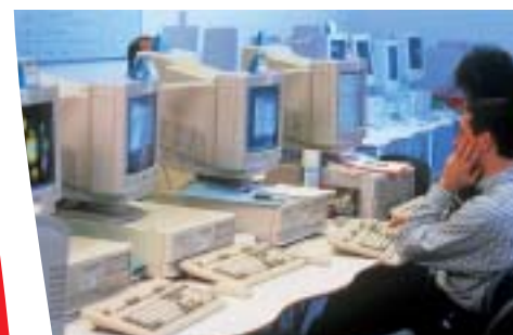
Servidores y unidades de almacenamiento de datos, equipamiento de networking...
