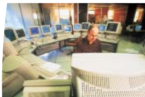
Compensación armónica de los sistemas de alimentación conmutadores, servidores, PC...
